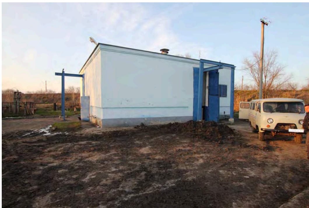
Рис. 17 – Главная канализационная насосная станция
