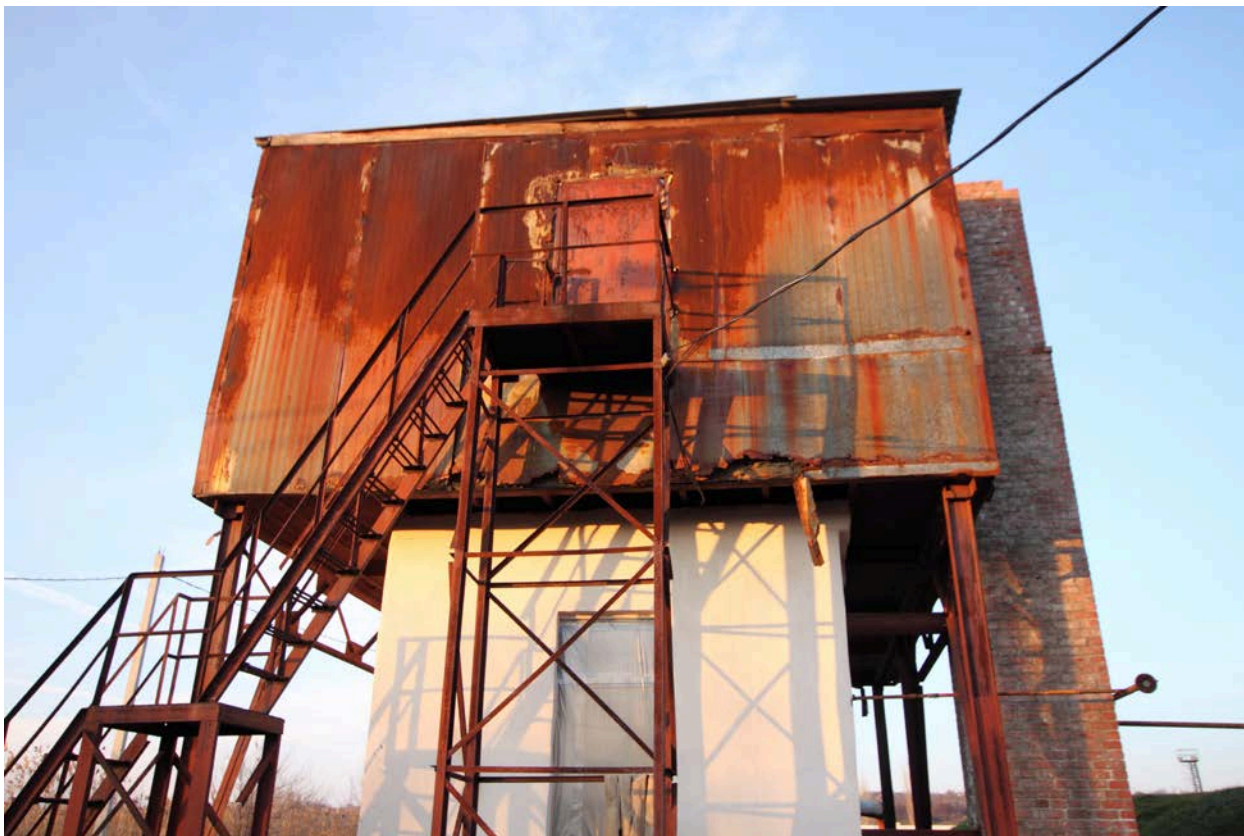
Рис. 19 – Общий вид здания УФС
