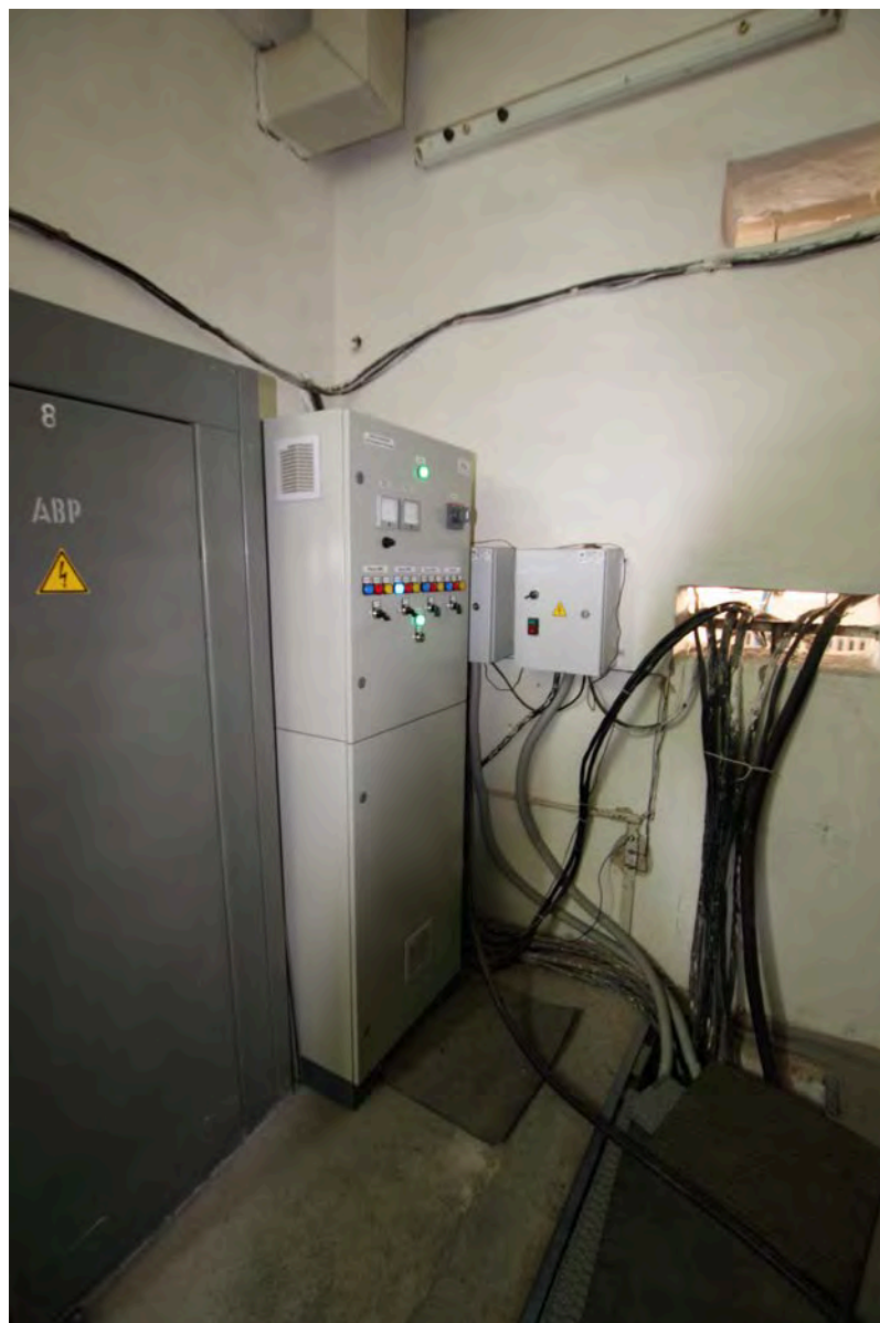
Рис. 10 – Станция управления частотными преобразователями НС - II
