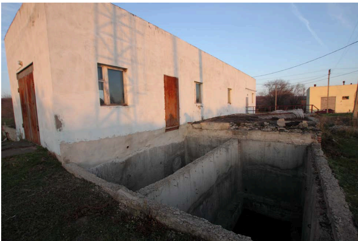
Рис. 21 – Недостроенный блок доочистки сточных вод
