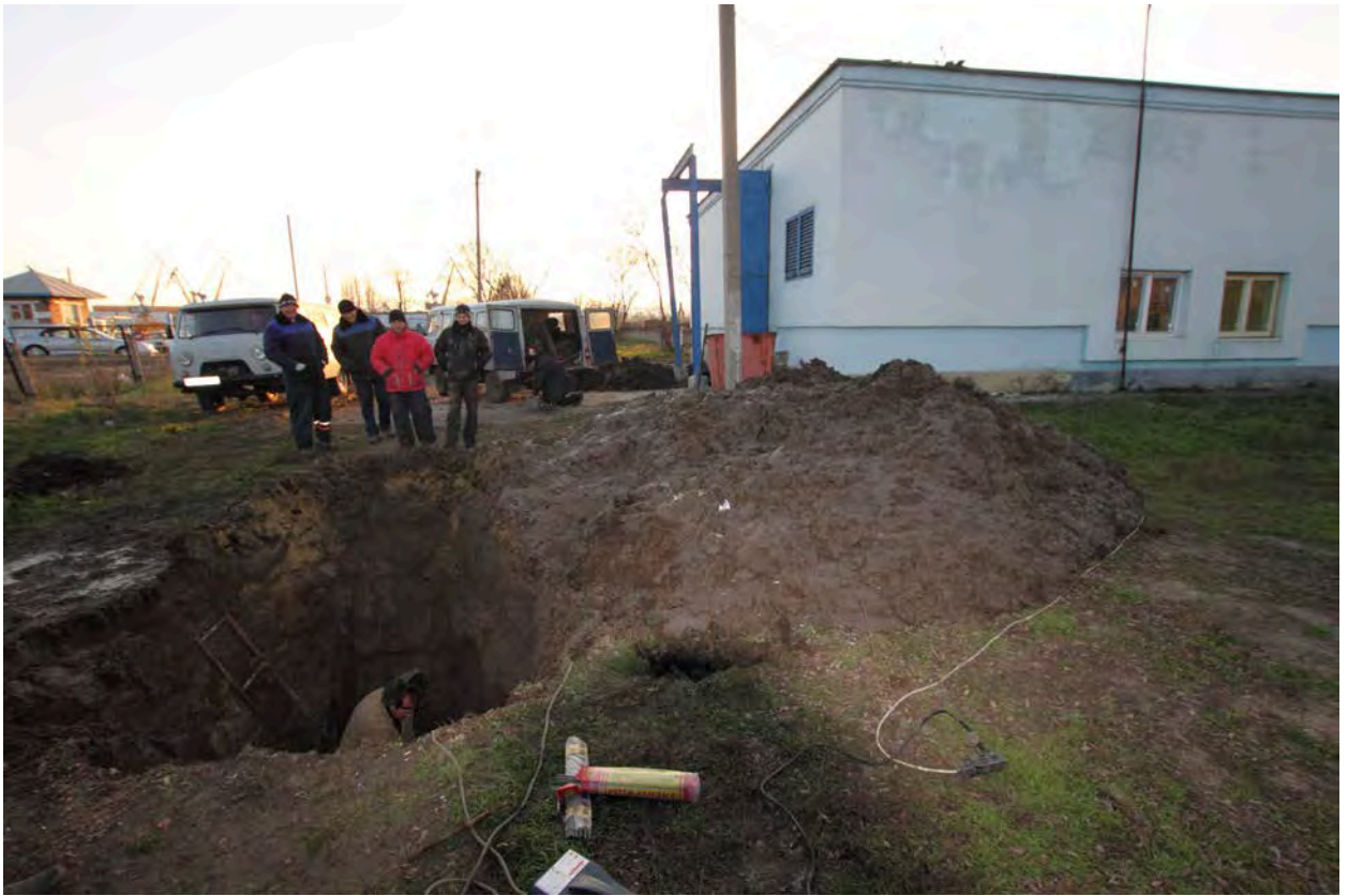
Рис. -18 Ремонт напорного коллектора возле здания ГКНС
