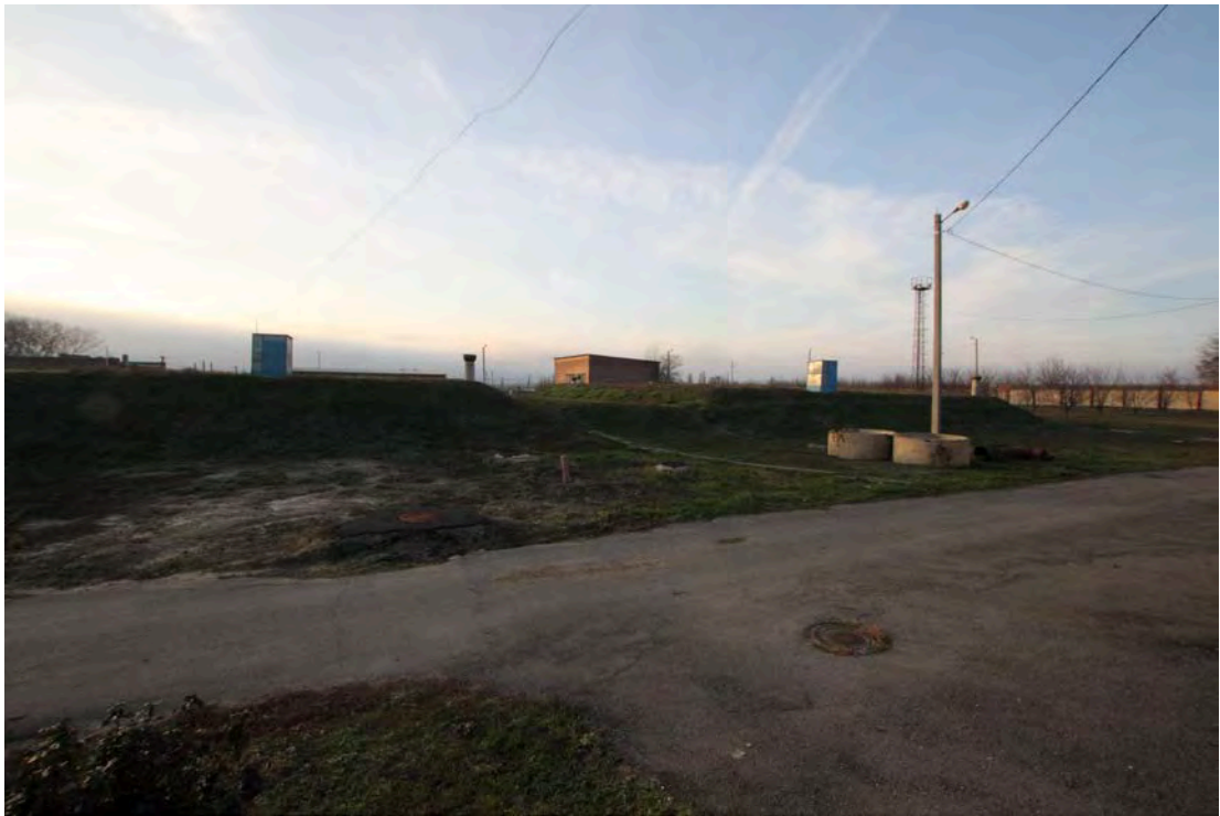
Рис. 6 – Резервуары чистой воды 2 по 3200 м 3
