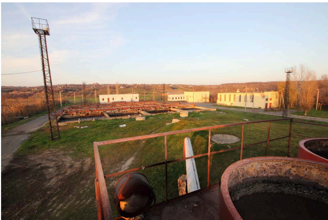
Рис. 14 – Общий вид канализационных очистных сооружений от здания УФС
